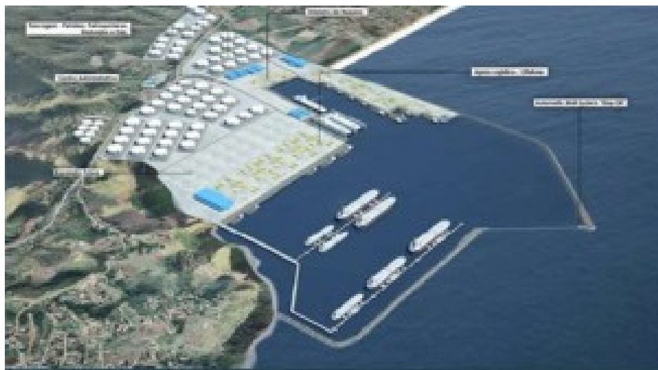
Projeto Terminais Ponta Negra (TPN) , na Praia de Jacomé, Maricá, RJ, Brasil, Paralisado por causa de processo no MP. Fonte da imagem: Petronotícias .
