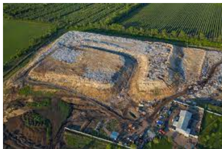
landuse=landfill (aterro sanitário)
