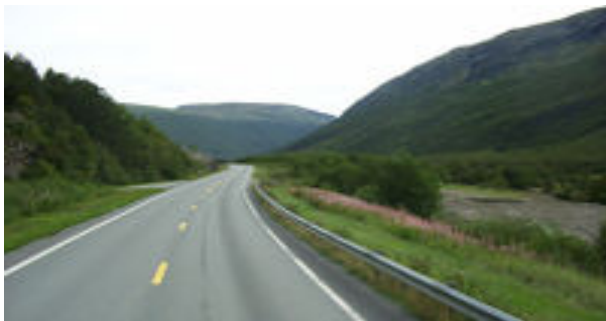
surface=asphalt Superfície asfaltada.
