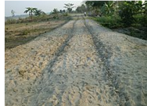
surface= sand Cobertura de areia.
